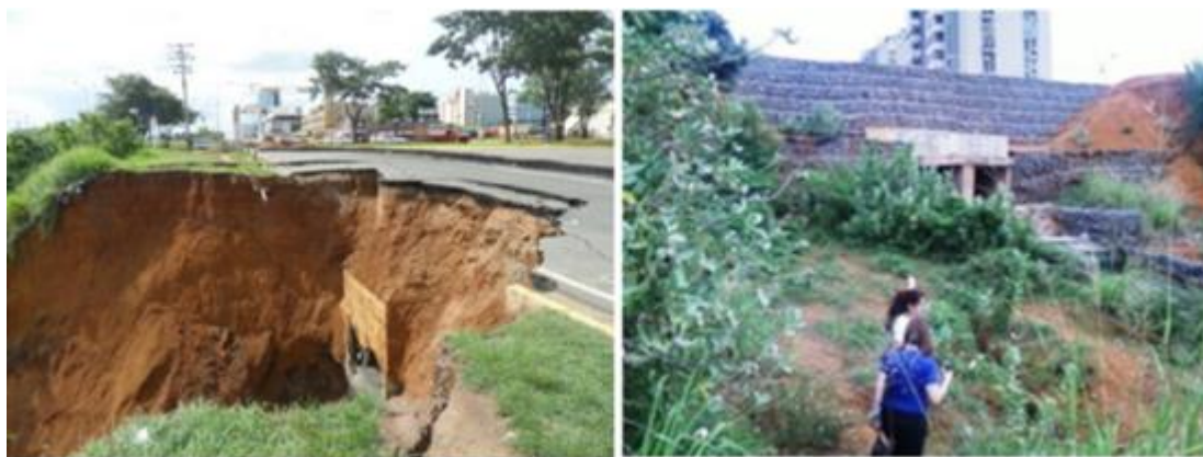
Figura 6. Antes y después de la cárcava de Villa Orinoquia, quebrada Toro Muerto en Alta Vista, Ciudad Guayana. Adaptado de Propuesta de manual para selección de alternativas de tratamiento para suelos colapsables, (p. 6-7), por Meixeira, (2012), Venezuela y Riesgo ambiental por amenazas asociadas a procesos de carcavamiento. Caso: Villa Orinoquia. Sector Alta vista. UD 245 Puerto Ordaz. Estado bolívar, (p. 10), por Silva, Silva y Valeri, 2014, Venezuela. Derechos reservados por Beatriz Meixeira, Gisela Silva, Raiza Silva y Carol Valeri.
