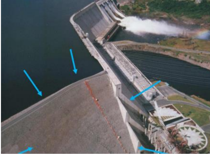
Figura 8. Ejemplo de revestimiento de presas de tierra con enrocado en la central hidroeléctrica “Simón Bolívar” con enrocado, se señala en la imagen la localización del mismo. Tomado de Las horas oscuras, (párr. 1), por Salomón, 2020, Venezuela; modificado por Tovar, (2023). Derechos reservados por Luisa Salomón.
