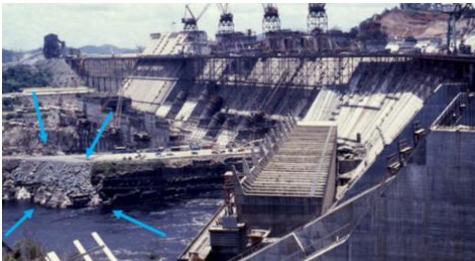
Figura 7. Revestimiento de presas de tierra en la central hidroeléctrica “Simón Bolívar” con enrocado, se señala en la imagen la localización del mismo. Tomado de Las horas oscuras, (párr. 5), por Salomón, 2020, Venezuela; modificado por Tovar, (2023). Derechos reservados por Luisa Salomón.
