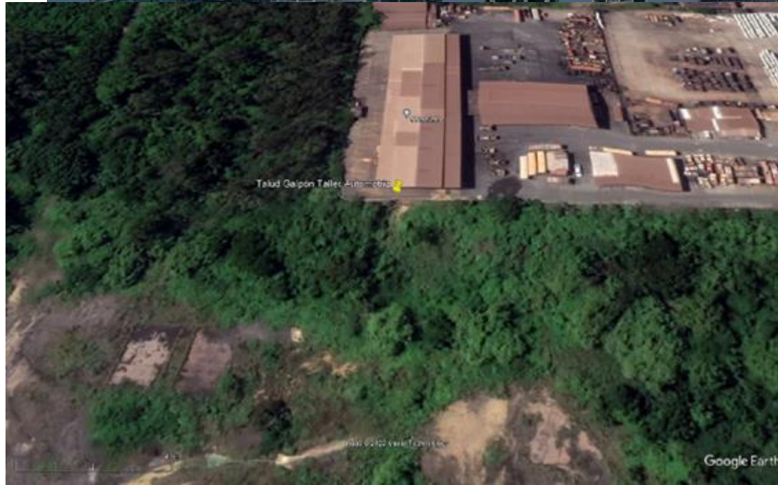
Figura 3. Localización de la zona de la cárcava objeto de estudio. Fuente: Google Earth, (2022).
